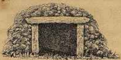
Подземная усыпальница въ с. Мцхетѣ.
