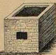
Усыпальница сложная изъ кирпича на р. Фортлаги.
