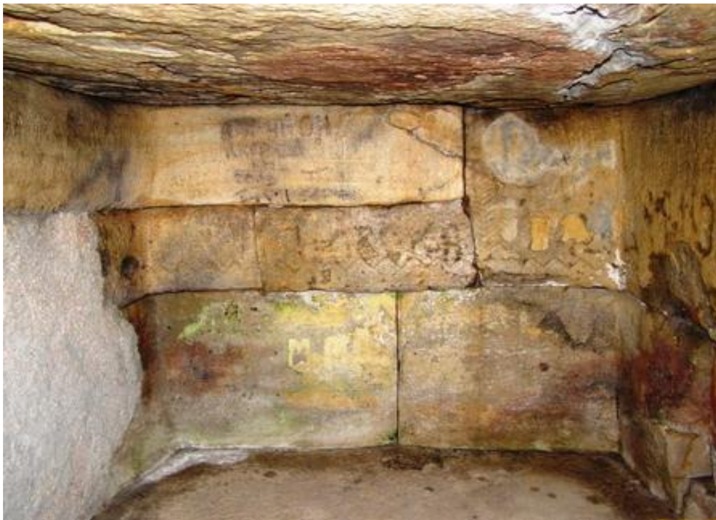
Камера Лунного дольмена сложена из Г-образных блоков
