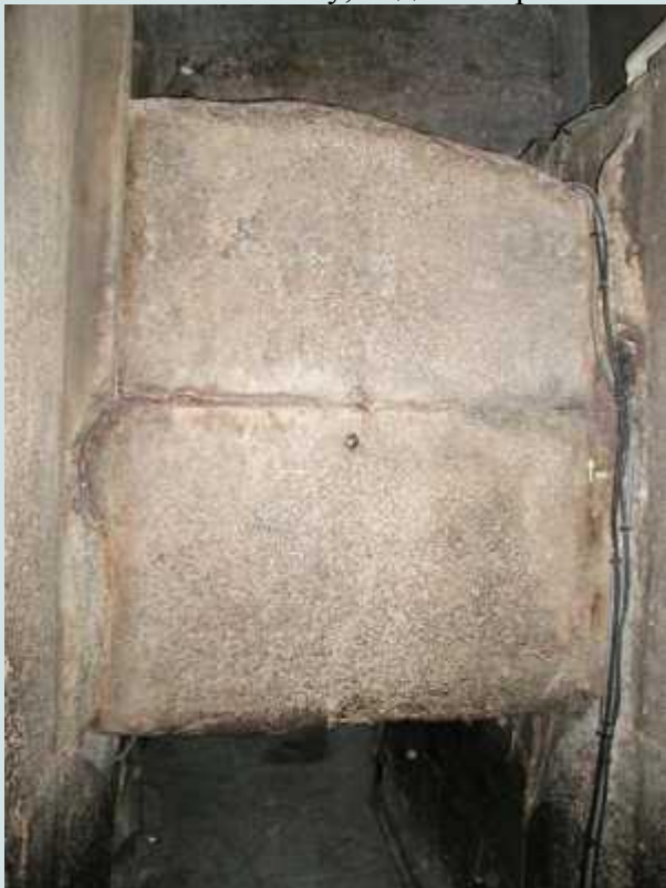
Рис.41 Заслонка в пазу, вид со стороны смесителя.
