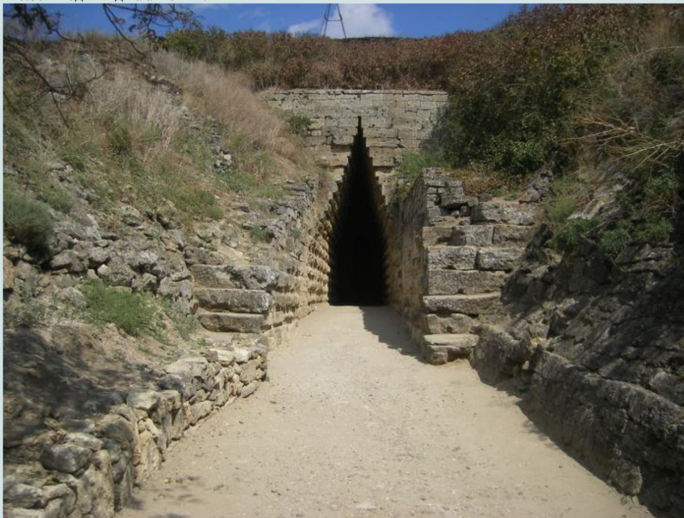
Рис.80 Вход и вид на антенны.
