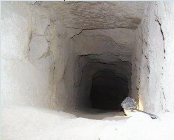
Рис.43 Вид эвакуационного колодца.
