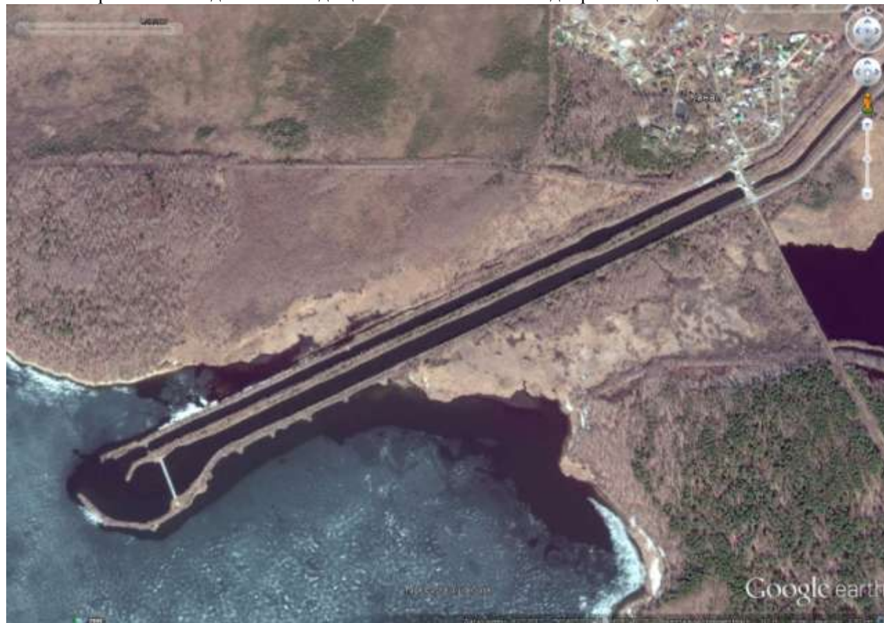
Рис.17 Современный вид канала входящего в Волчихинское водохранилище.
