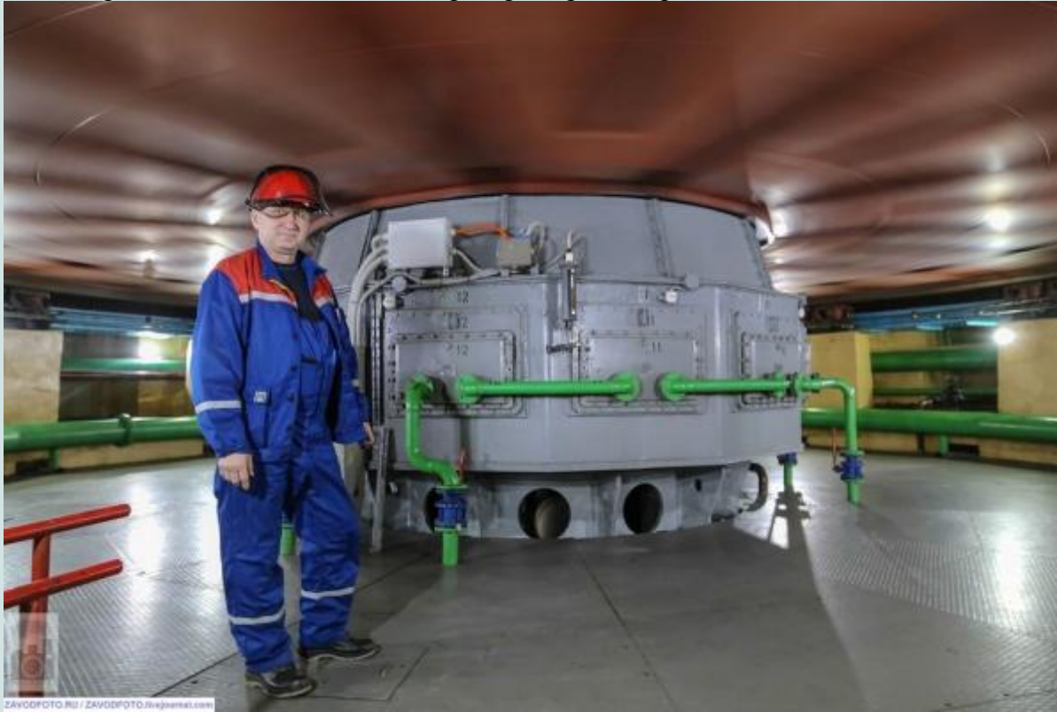
Рис.17 Вращающийся, многотонный ротор гидроэлектростанции.
